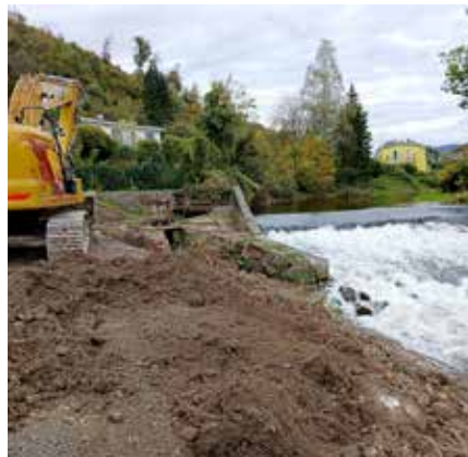
Baustart Kraftwerk Muntigl und Sanierung Stuböckwehr
