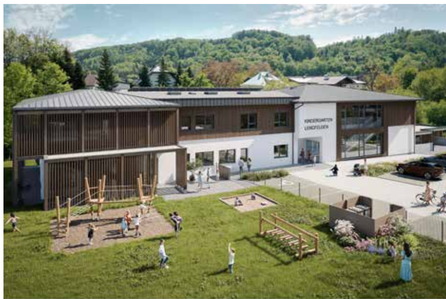
Wir freuen uns auf die Fortschritte auf der Baustelle und vor allem auf das, was dort entstehen wird: ein Haus voller Leben, Lachen und Zukunft.
