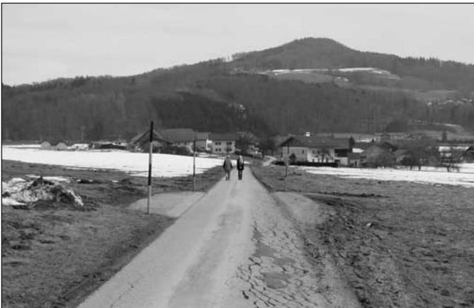
*Gänzlich kaputt ist der Überfuhrweg. Er muss samt Unterbau komplett erneuert werden. Das kostet stolze 220.000 Euro. An der Finanzierung beteiligt sich auch die Baufirma Hinteregger, deren LKW's beim Bau der Sohlstufe in der Salzach den Überfuhrweg beschädigt haben.*
